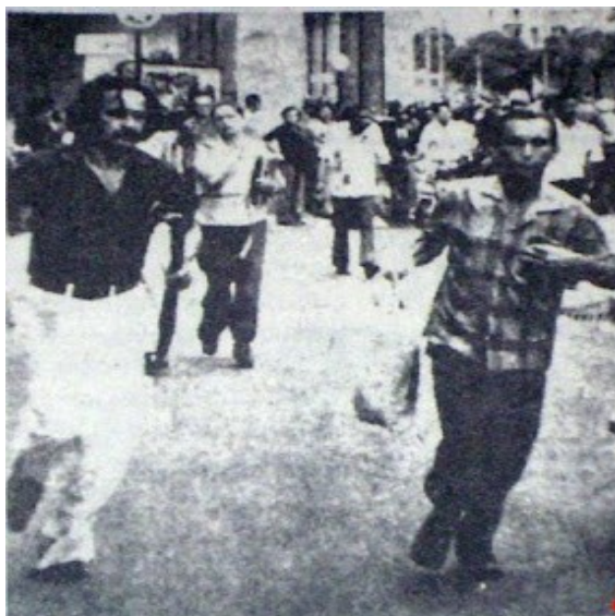
Foto: Avenida Guararapes. Pânico coletivo no Recife. Boato que a Barragem de Tapacurá tinha estourado gera pânico no Recife. 10h do dia 21 de julho de 1975. DP 17.07.2005 ( http://falhistoria.blogspot.com/2010/11/tapacura-estourou.html ).
