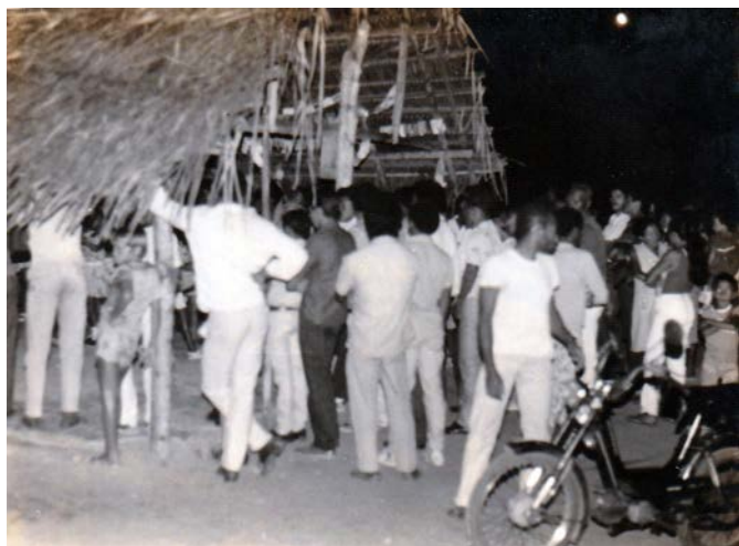
Fig. 22 - Pavilhão de festas da comunidade de Gurugi
